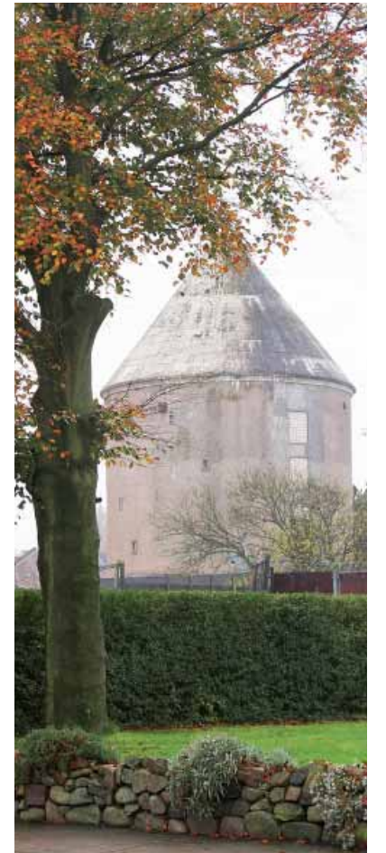
Discobunker an der Steinstraße
